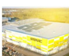
Die Lagerung von hochwertigen Lebensmitteln und Health Care trifft den Puls der Zeit. Primär für diese Zwecke dient der Neubau der Halle 6, deren Innenausbau in vollem Gange ist. Neben der bereits installierten Photovoltaikanlage wird die Halle final über KfW 55 Standard, Luft-Wärmepumpen-Heizung, effiziente Lichtsteuerung und Temperaturmonitoring verfügen. Zusätzlich wird es neue Trailer-Parkplätze geben.
